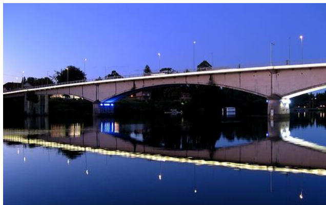
Actual Puente Pedro de Valdivia en Valdivia
